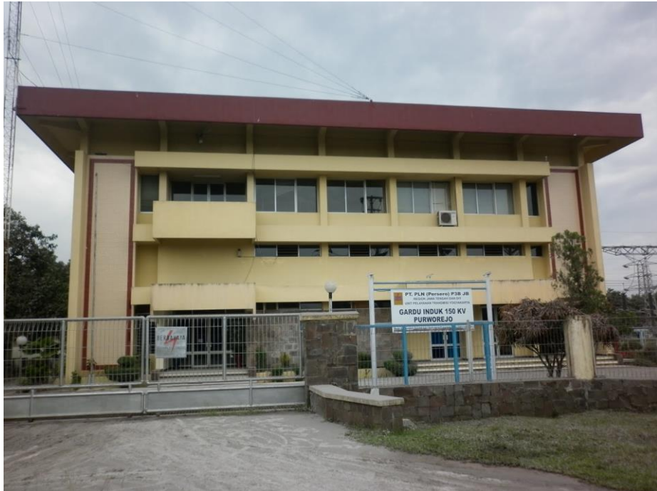
Gambar 3. Gardu Induk 150 kV Purworejo
