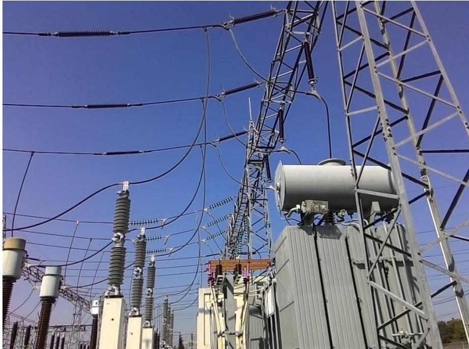
**Gambar 4.5** Jarak penempatan antara Arrester dan Transformator
