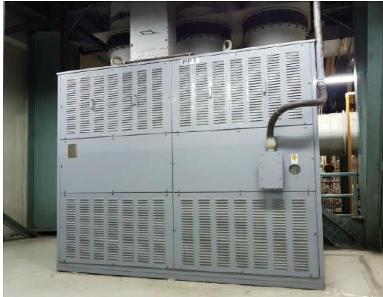
Gambar 4.2 Transformator Eksitasi pada PLTU Unit 1 dan 2
