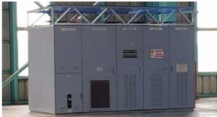
Gambar 4.5 AVR (Automatic Voltage Regulator) pada PLTU di PT PJB UP Gresik
