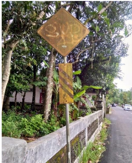
Gambar 4.4 Rambu tambahan peringatan No.22a dan No. 24 arah utara
