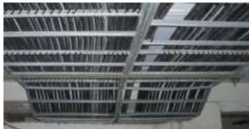
Gambar 2. 34 Ladder kabel di atas plafond
