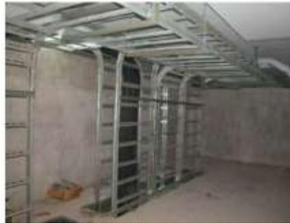
Gambar 2. 35 Ladder kabel di dinding
