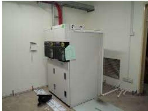
Gambar 2. 1 Panel Tegangan Menengah
