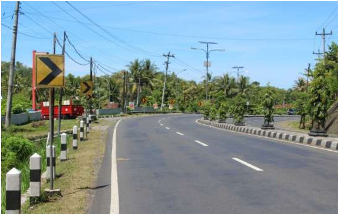
Gambar lampiran : 5. Foto kondisi tikungan pertama
