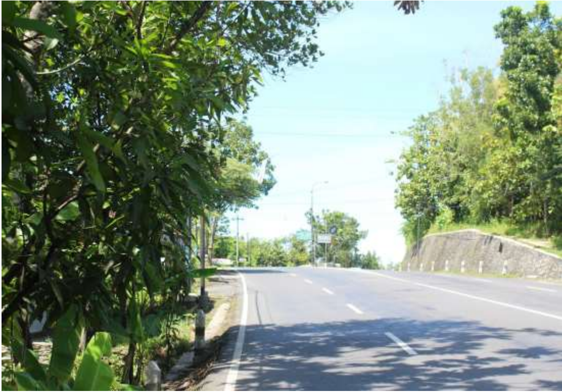
Gambar lampiran : 1. Foto kondisi bahu jalan
