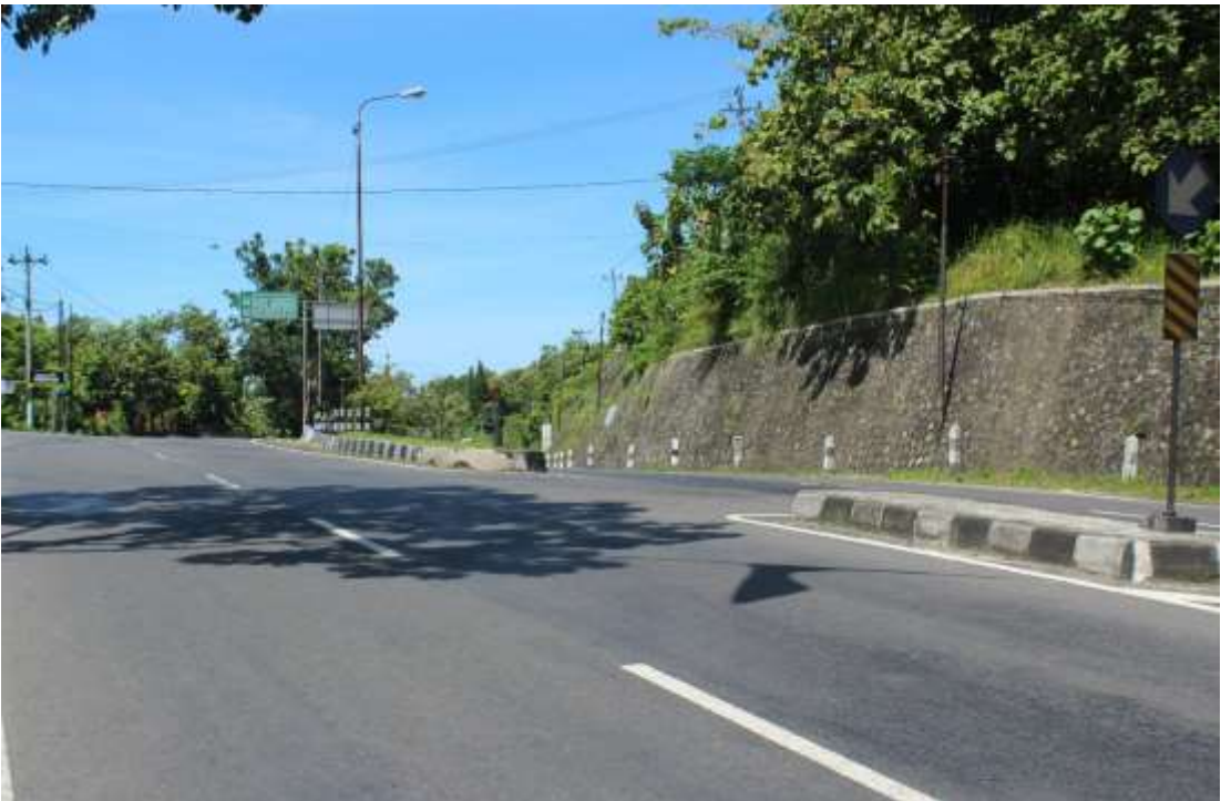
Gambar lampiran : 2. Foto kondisi U-Turn dan pembatas jalan
