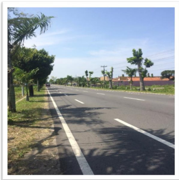
Gambar 4.19 Tidak Ada Rambu Peringatan Batas Maksimum Kecepatan
