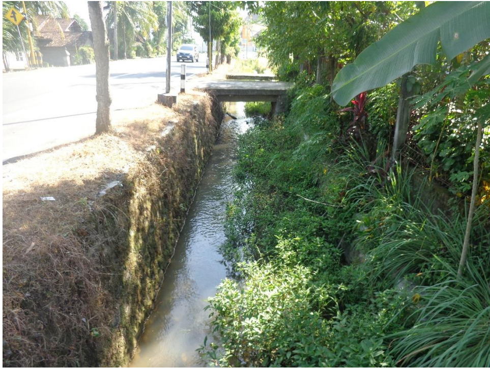
Gambar 4.26 Drainase Terbuka dan Kurang Terawat
