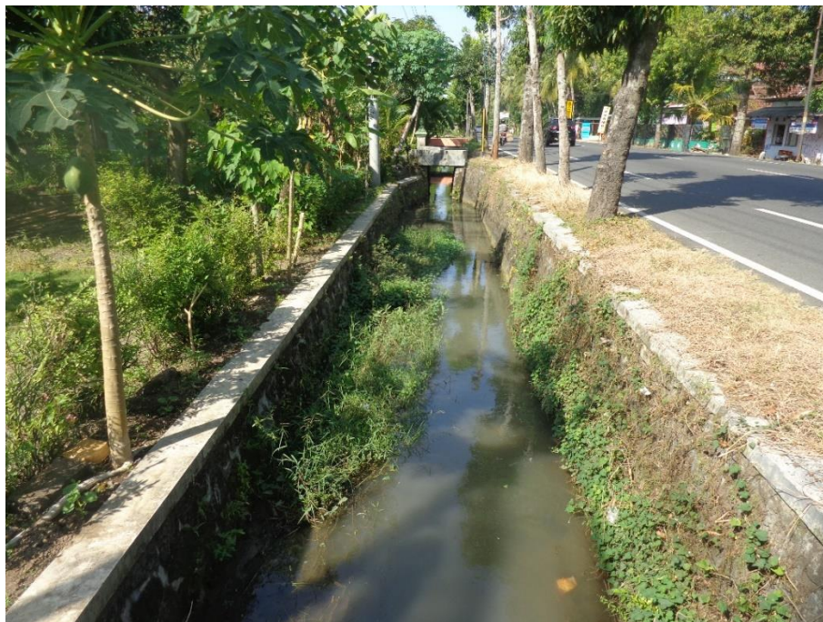
Gambar 4. 22 Saluran Drainase Terbuka
