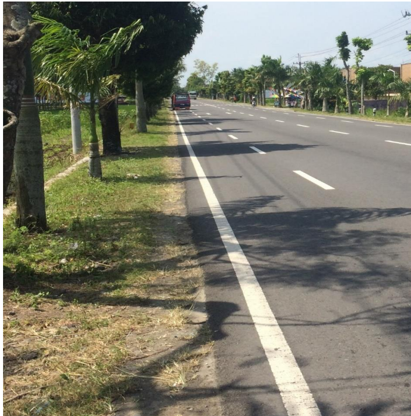
Gambar 4. 11 Kondisi Kiri dan Kanan Jalan Banyak terdapat Pohon
