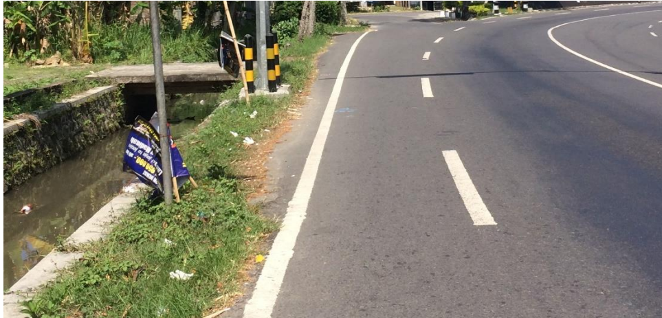
Gambar 4.14 Ukuran Bahu Jalan yang Kecil
