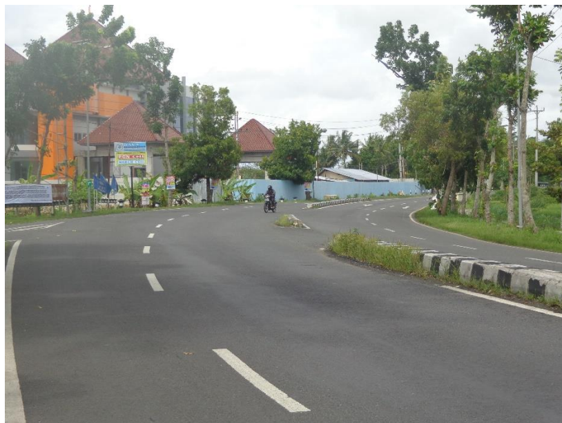
Gambar 4.13 Median Jalan yang Terputus
