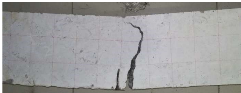
Gambar 4.5 Retak pada saat beban maksimum beton normal
