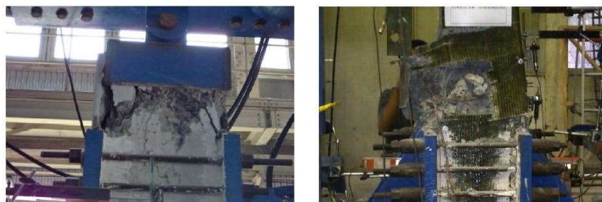
Gambar 2.2 Sebelum perbaikan dan setelah perbaikan (Parmo dkk., 2013)
