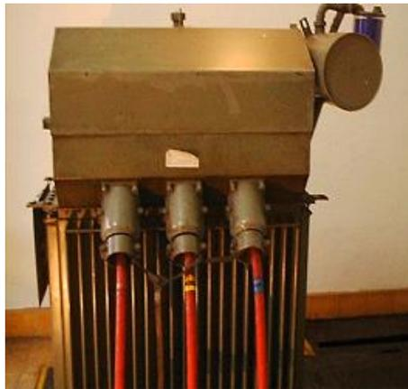
**Gambar 2. 14** Transformator Pemakaian Sendiri (TPS)
