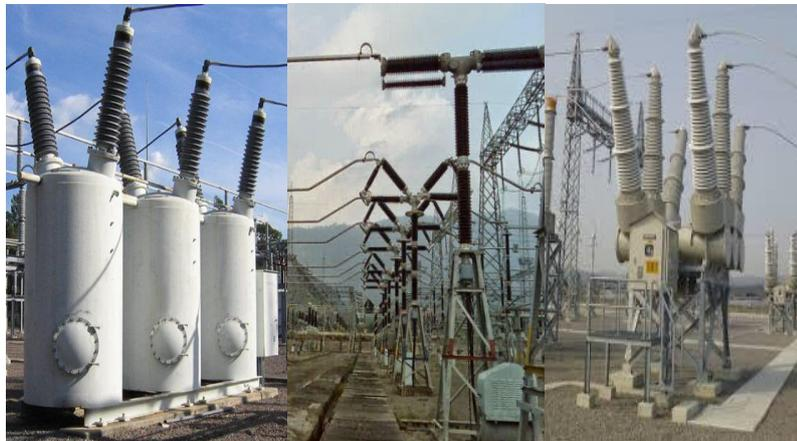
a. Minyak (OCB)      b. Udara (ACB)      c. Gas (GCB)
