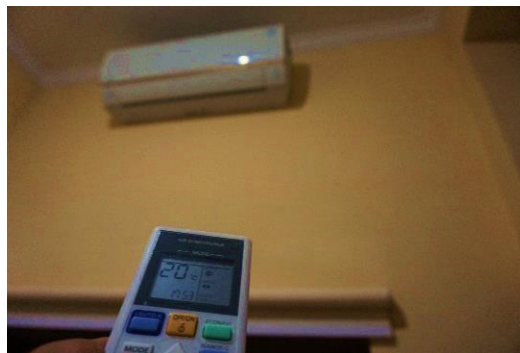
Gambar 2. 1 AC controller menggunakan remote
