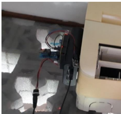
Gambar 13. Pengukuran Suhu ruangan
