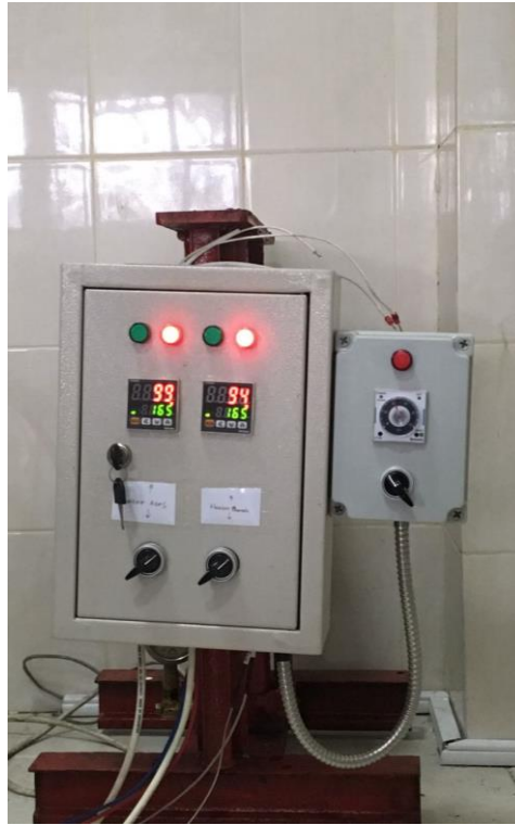
Gambar 3.30 pengaturan suhu pada panel
