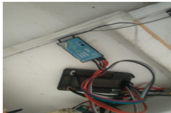
Gambar 4.45 pemasangan Receiver pada pesawat
