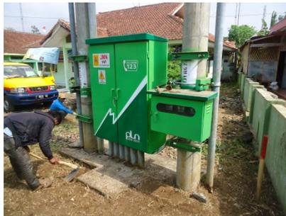
Gambar 2.12. Gardu Tegangan Menengah PLN
