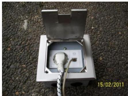
Gambar 2.4 Kotak kontak lantai
