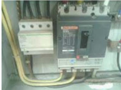
Gambar 2.35 Contoh instalasi *arrester* pada jaringan kelistrikan
