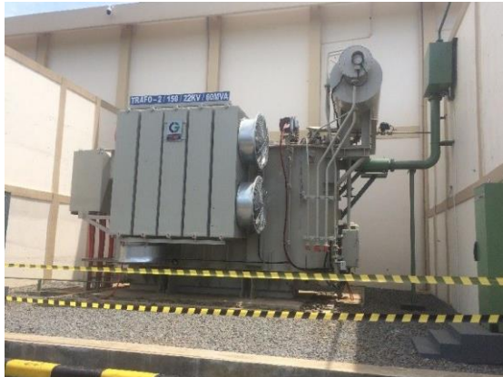
Gambar 2.4 Gardu Induk Setengah pasang Luar
