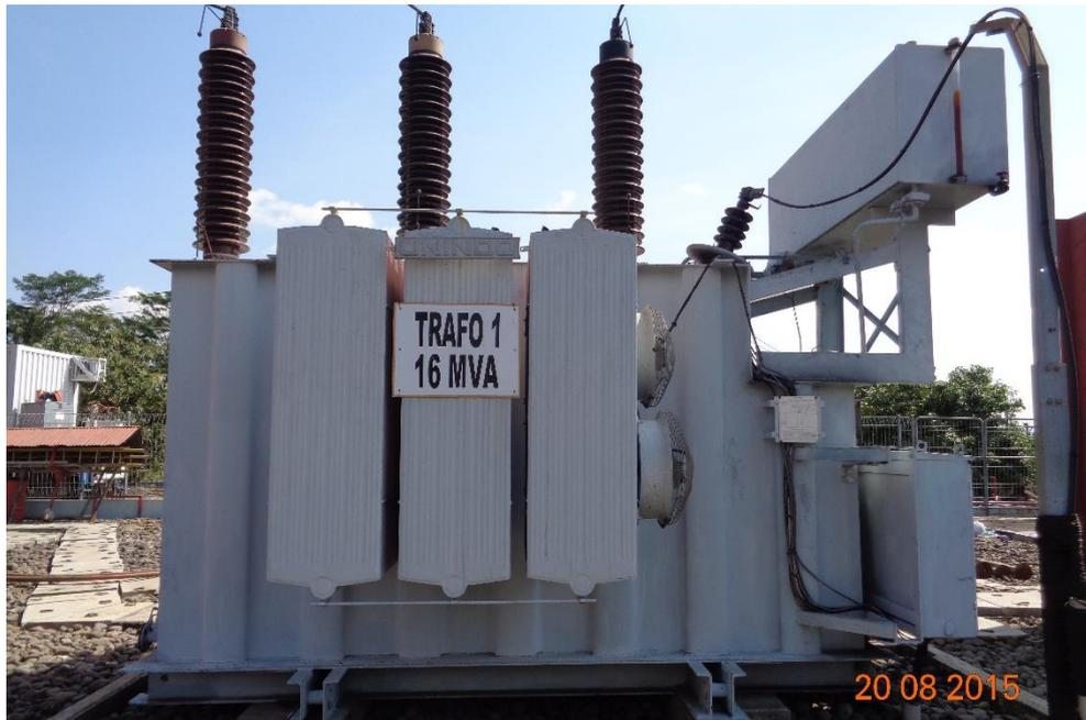
**Gambar 3.2** Transformator I (lama) berkapasitas 16 MVA 150/20 KV
