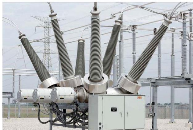
**Gambar 2.8** Pemutus Tenaga (PMT) atau *Circuit Breaker* (CB)
