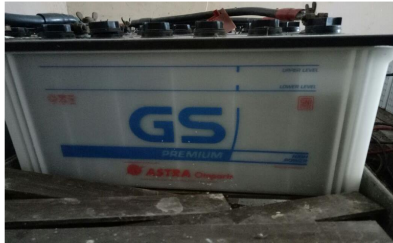
Gambar 4.8 Baterai atau Aki GS Astra 100 Ah/12 V (Sumber: Dokumentasi pribadi)
