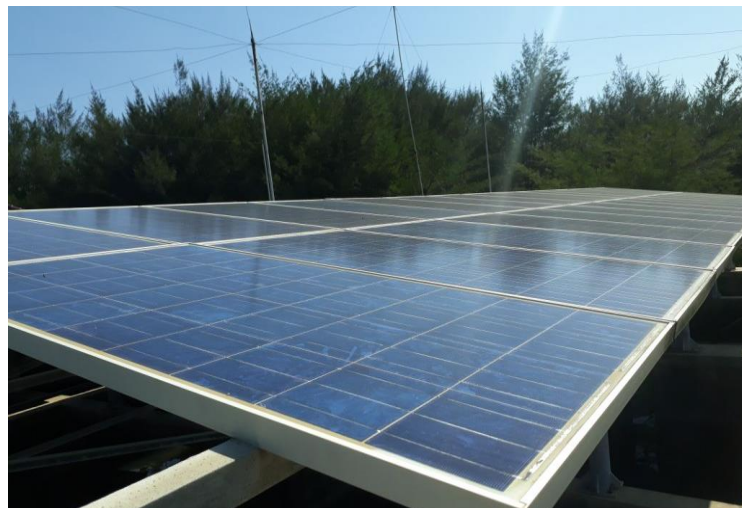
Gambar 4.4 Sel dan Modul Fotovoltaik (PV) Jenis Polikristal (Sumber : Dokumentasi pribadi)
