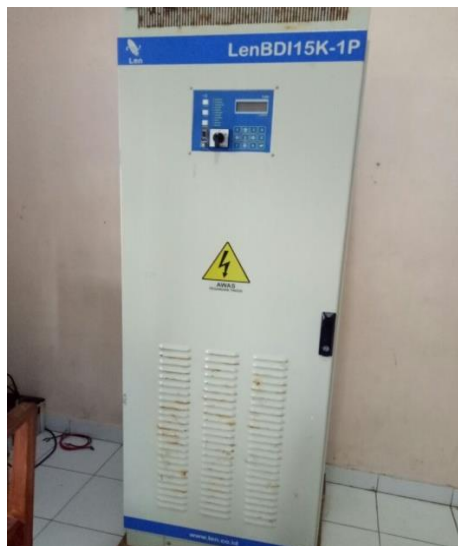
Gambar 4.13 Inverter len BDI15K-1P 15 kw 240 V (Sumber: Dokumentasi pribadi)
