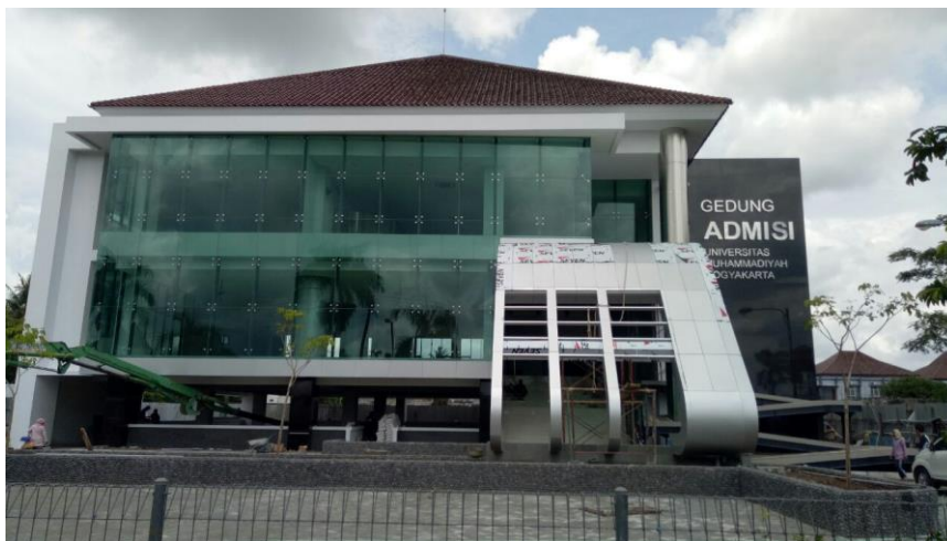
Gambar 3.1. Lokasi Gedung Admisi Universitas Muhammadiyah Yogyakarta
