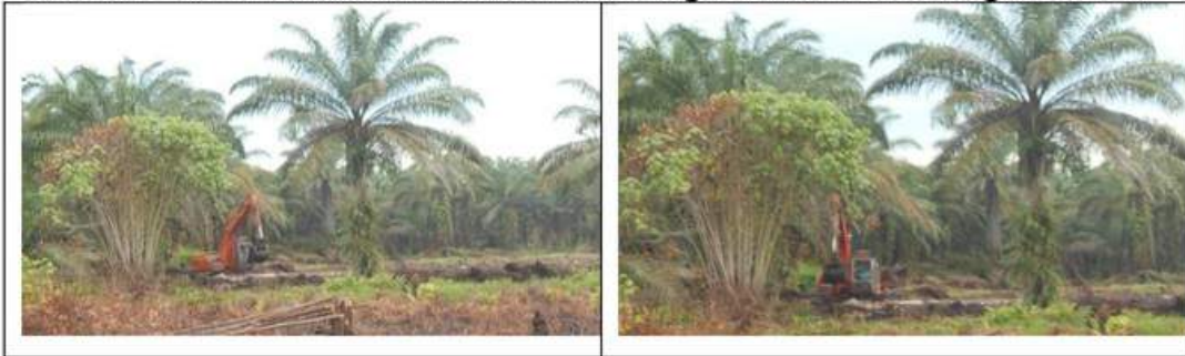
Gambar 4.25 Alat berat milik investor digunakan membangun kanal
