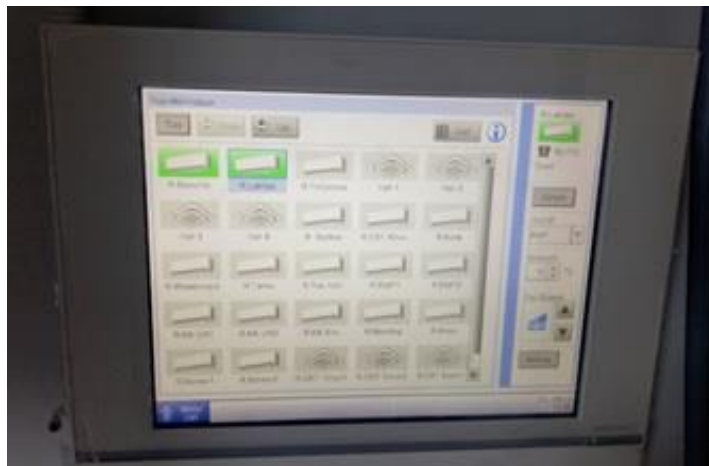
Gambar 2.18 Central Control Canggih untuk Unit Indoor VRV IV (Sumber gedung Admisi UMY)
