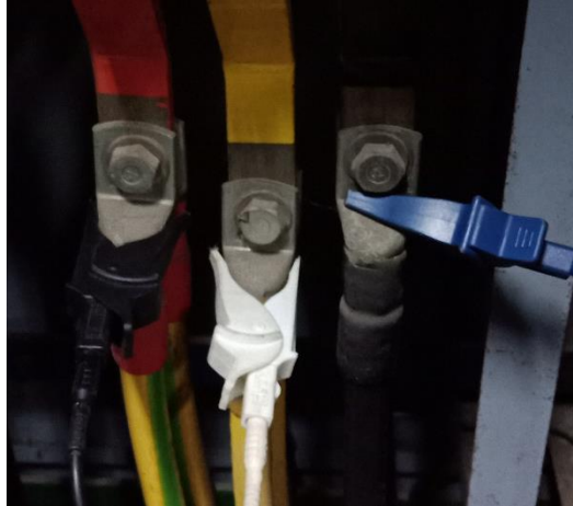
Gambar 4.5 Pemasangan Clamp Tegangan
