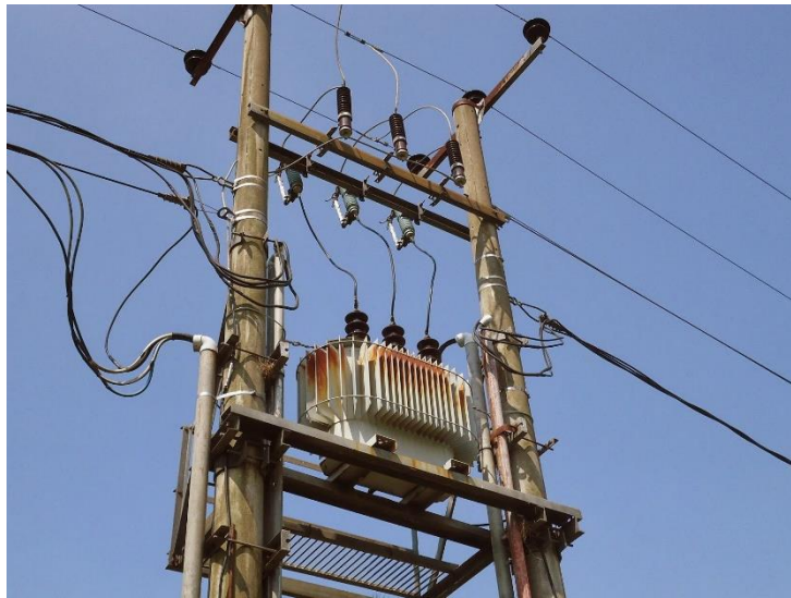
Gambar 2.5 Konstruksi gardu distribusi
