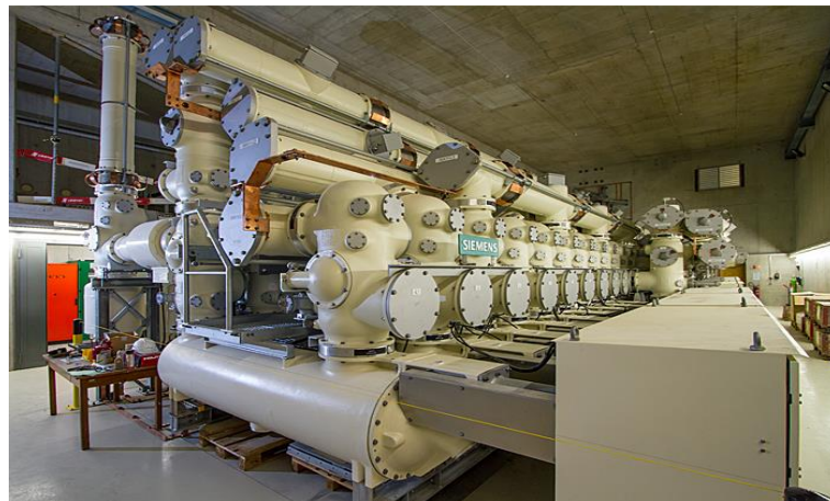
Gambar 2.3 Gardu induk pasangan dalam
