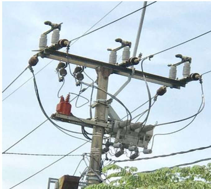
Gambar 2.8 Jaringan distribusi primer 20 kV
