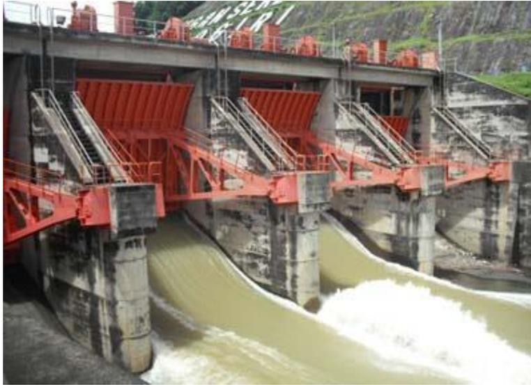
Gambar 2.4 *Main Spillway* bendungan waduk gajah mungkur
