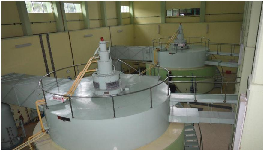
Gambar 2.5 Generator sinkron unit 1 dan unit 2 PLTA Wonogiri.
