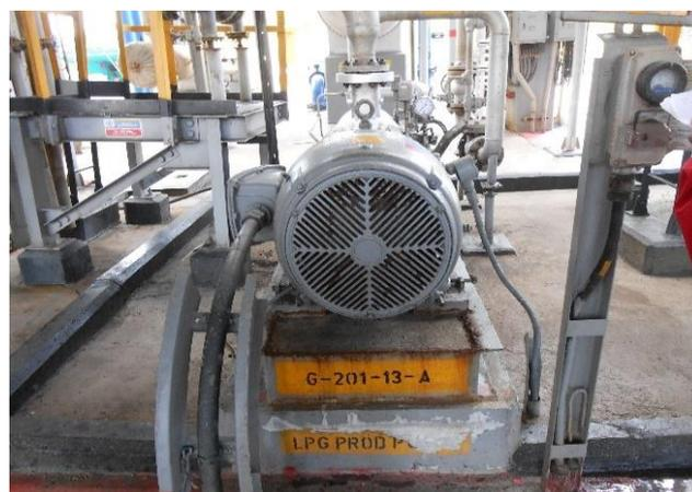
Gambar 3.4 Motor Pompa GM 201-13A sebagai *Desalter Water Pump*
