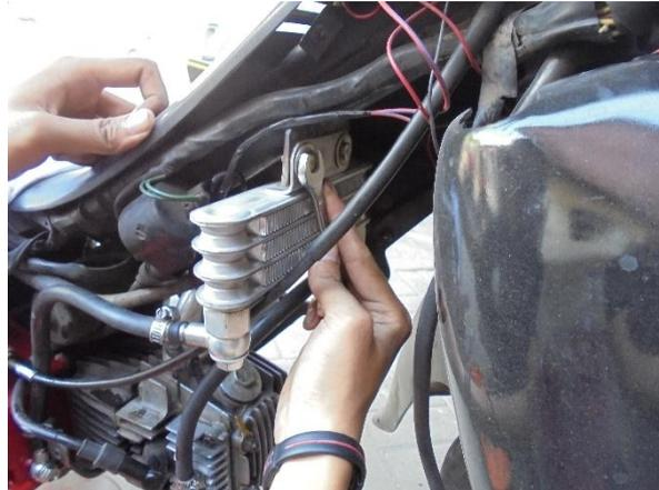
**Gambar 4.3** Pemasanganudukan dan baut *cooler*
