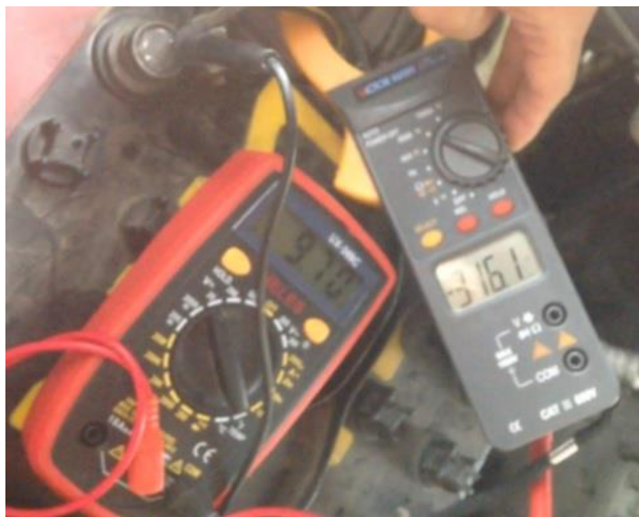
Gambar 4.6 Pengukuran Motor Starter Tanpa Kapasitor Bank
