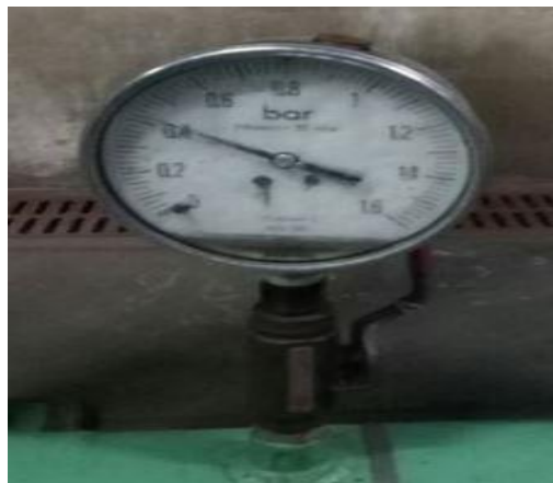
Gambar 2.10 Pressure Switch (Sumber : dokumentasi pribadi)
