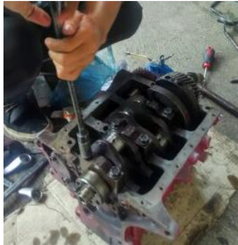
Gambar 3.24 Pengendoran baut pada main bearing cap
