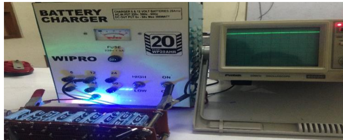
Gambar 4.7 Pengisian Kapasitor Bank dengan Battery Charge 20AH
