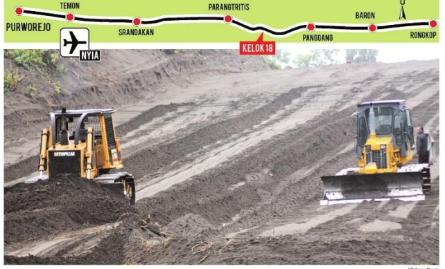
Alat berat mengerjakan proyek pembangunan JJLS di Grogol Desa Parangtritis Kretek Bantul, Minggu (29/1).
