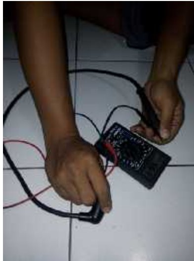
Gambar 4.7 Pemeriksaan Dan Pengukuran Kabel Tegangan Tinggi
