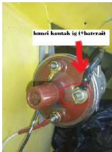
Gambar 4.16 Pemasangan Rangkaian Kabel Pada Terminal Pada Ignition Coil
