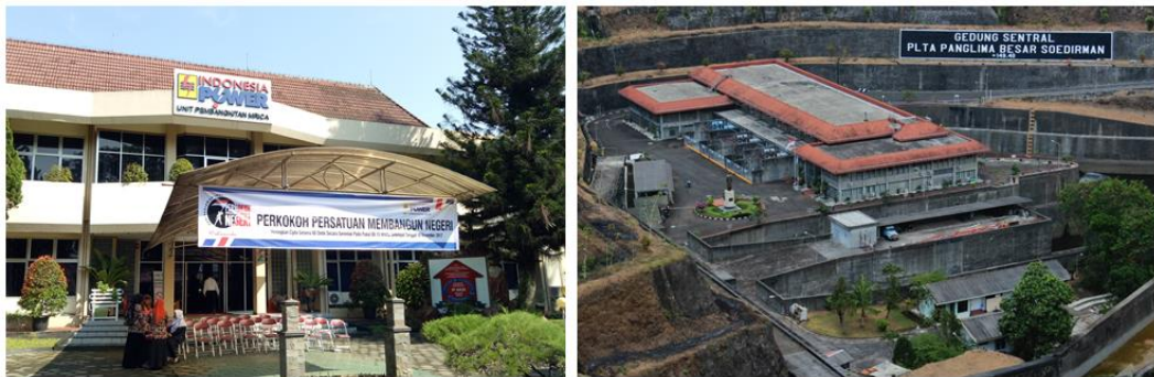
Gambar 3.1. Foto Instansi PT.INDONESIA POWER UP Mrica dan sub unit PLTA PB SOEDIRMAN (Sumber : PLTA PB SOEDIRMAN, 2017)
