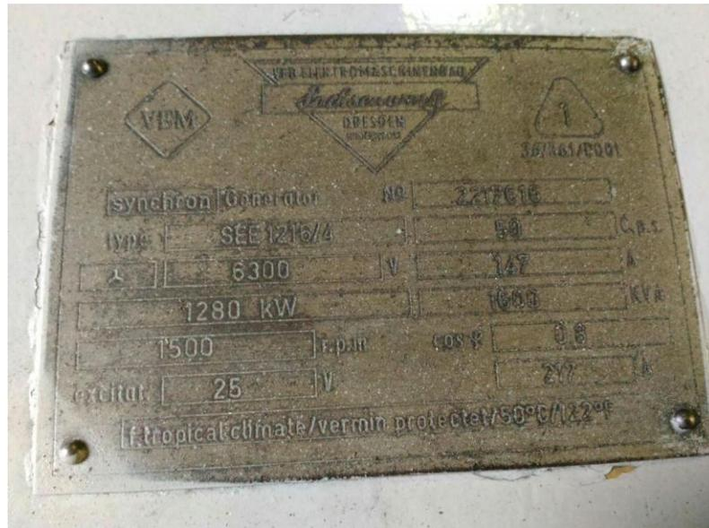
Gambar 4.1 Nameplate pada generator tenaga uap di PT. Madubaru
