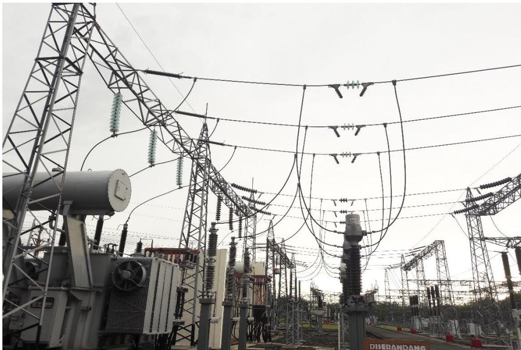
Gambar 4.1 Jarak penempatan arrester dan transformator di Gardu Induk Bantul 150 kV
