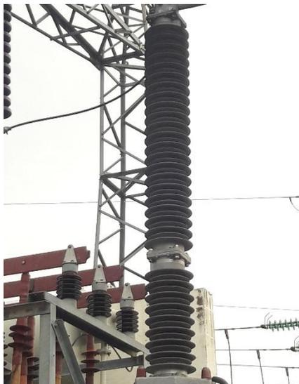
Gambar 2.40 Arrester pada transformator tenaga III
