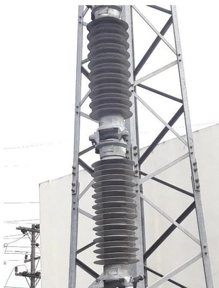
Gambar 2.38 Arrester pada transformator tenaga I
