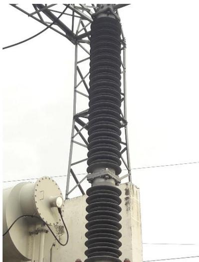
Gambar 2.39 Arrester pada transformator tenaga II
