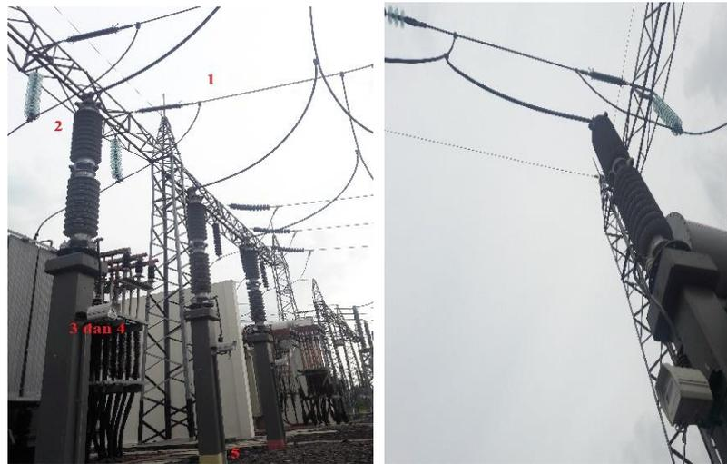
Gambar 2.24 Posisi pemasangan perlengkapan arrester
