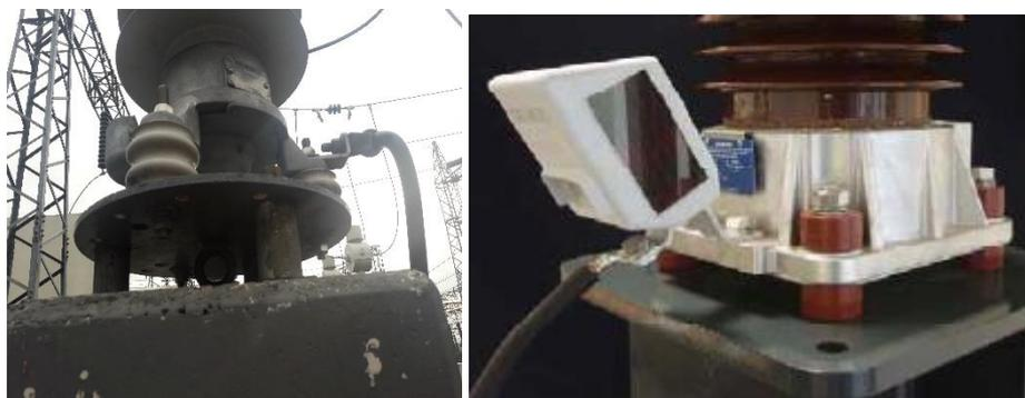
Gambar 2.21 Isolator dudukan arrester
