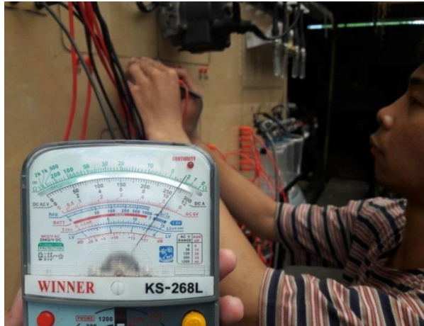
Gambar 4.14 Pemeriksaan tahanan terminal NE dan G distributor
