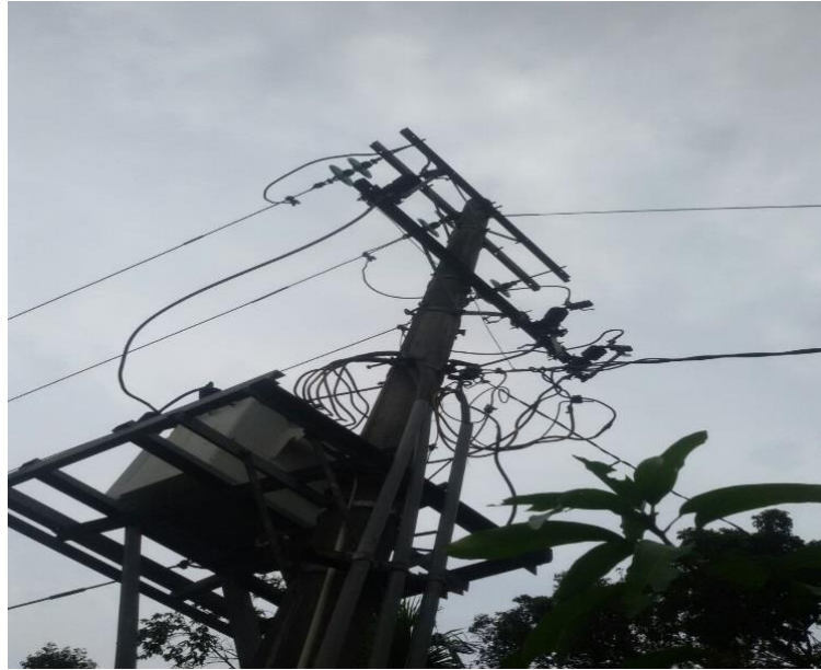
Gambar 2.4 Jaringan Distribusi Primer 20 kV
