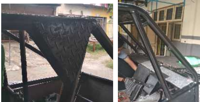
Gambar 4.11 Reinforcement pada tubular.
