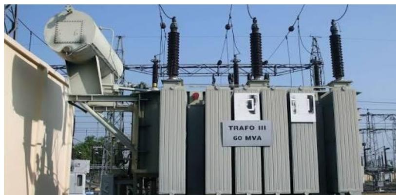
Gambar 3.2 Trafo 3 60 MVA Gardu Induk 150 kV Bantul
