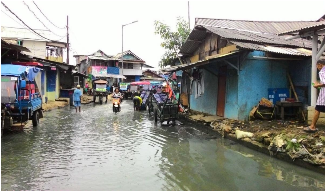
Gambar 0.5 Dataran rendah muara akibat reklamasi sehingga Drainase aliran air menuju teluk Jakarta tidak mengalir dengan mudah.
