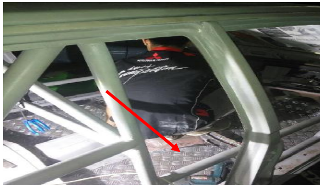
Gambar 4.11 Pemasangan Plat Bordes .
