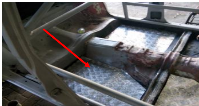
Gambar 4.12 Pemasangan Plat Bordes .
