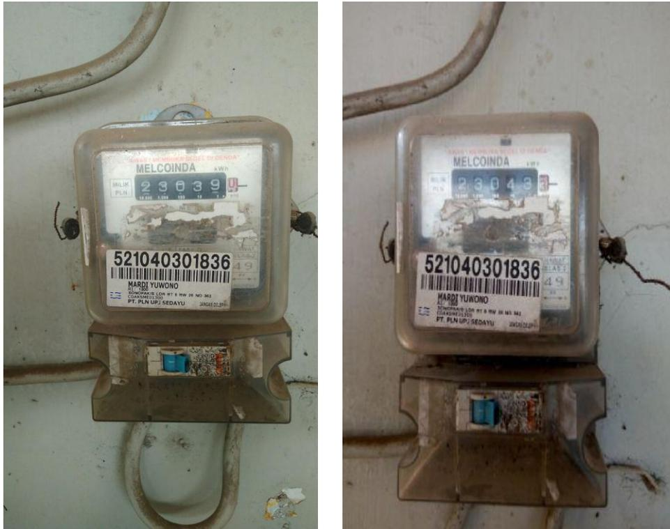
**Gambar 4.9** Kwh Meter Analog
