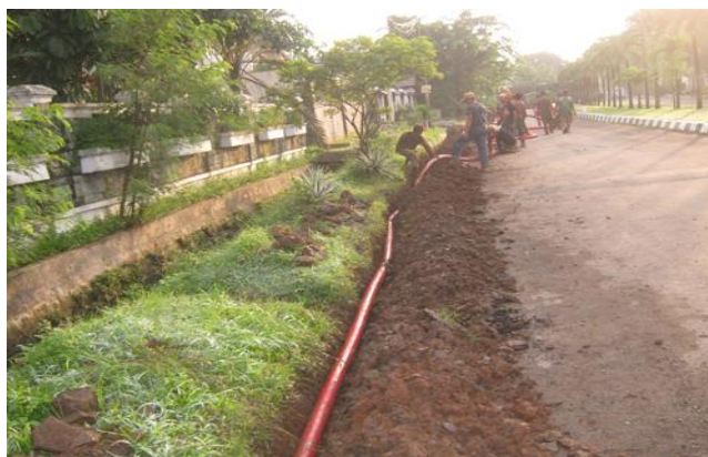
Gambar 2.5 Saluran Kabel Bawah Tanah
