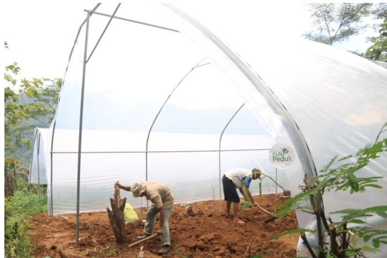
Gambar 3.9 Proses pembuatan kubung krisan bantuan program bina lingkungan PT PLN (Persero) Area Yogyakarta
