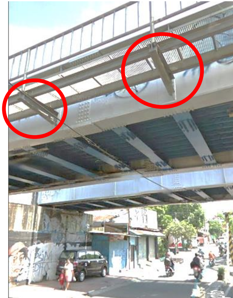
Gambar 2. Contoh penerapan balok baja kantilever dengan penampang non-prismatis
