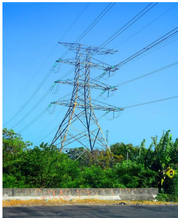
Gambar 2. 6 Saluran Udara Tegangan Ekstra Tinggi
